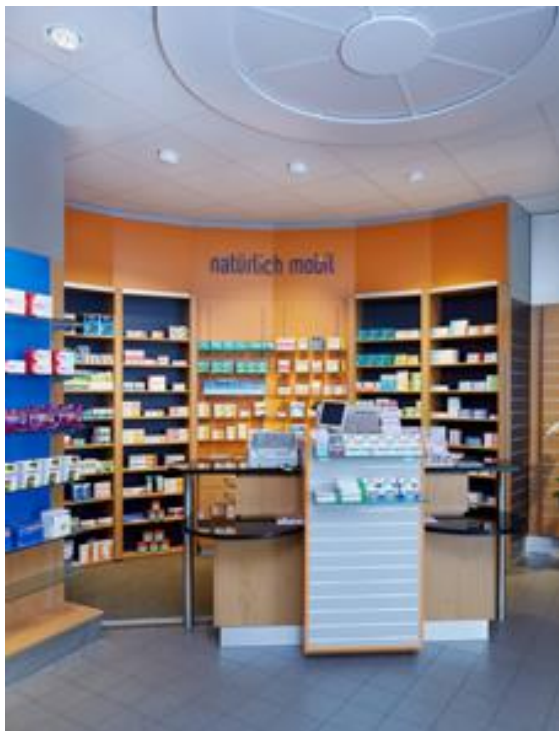
Akustikkassettenabdeckung nimmt deutlich besser den Tritt- und Umgebungsschall auf
